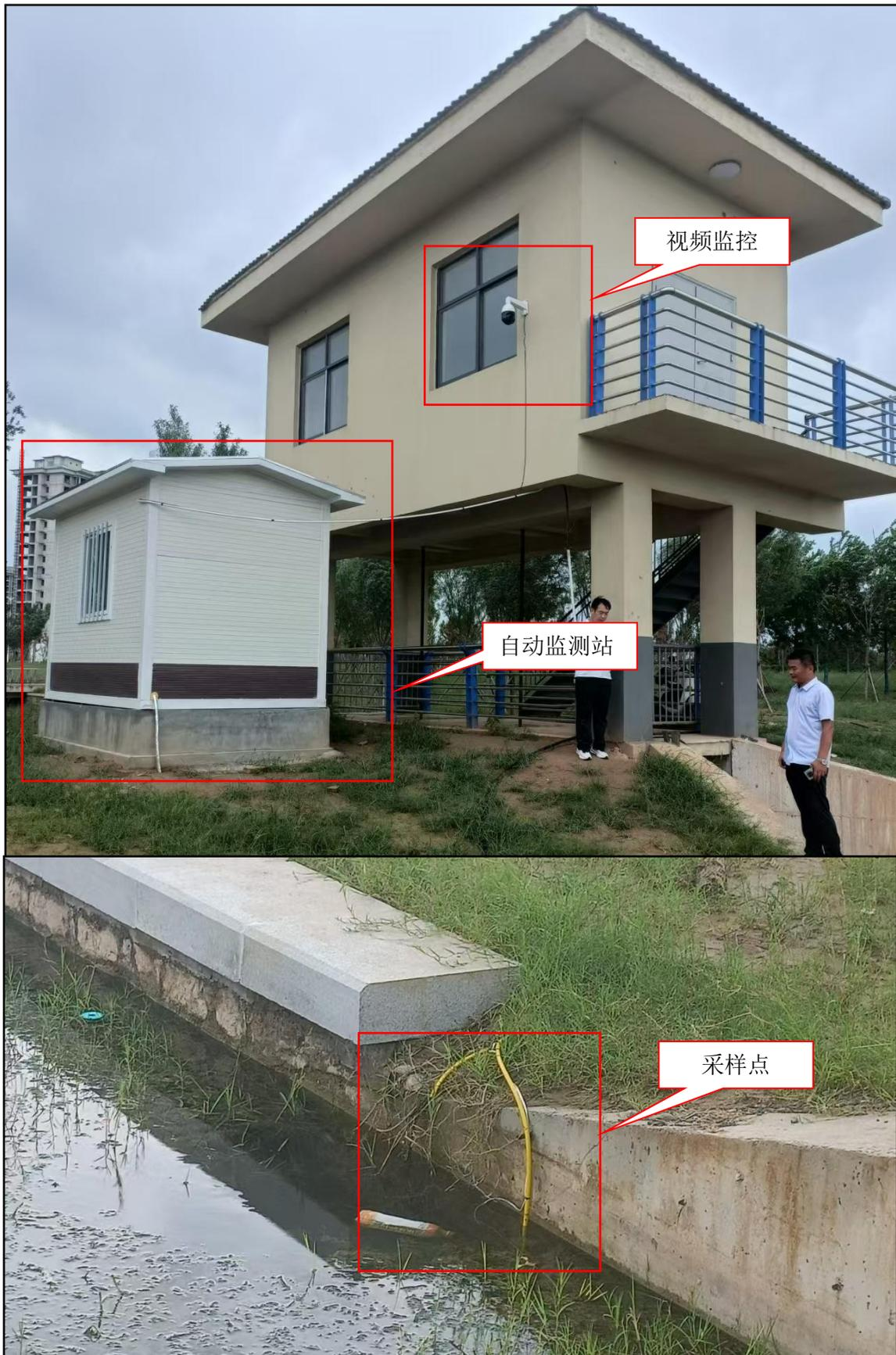
图 4.3-5 2#退水闸水质自动监测站
