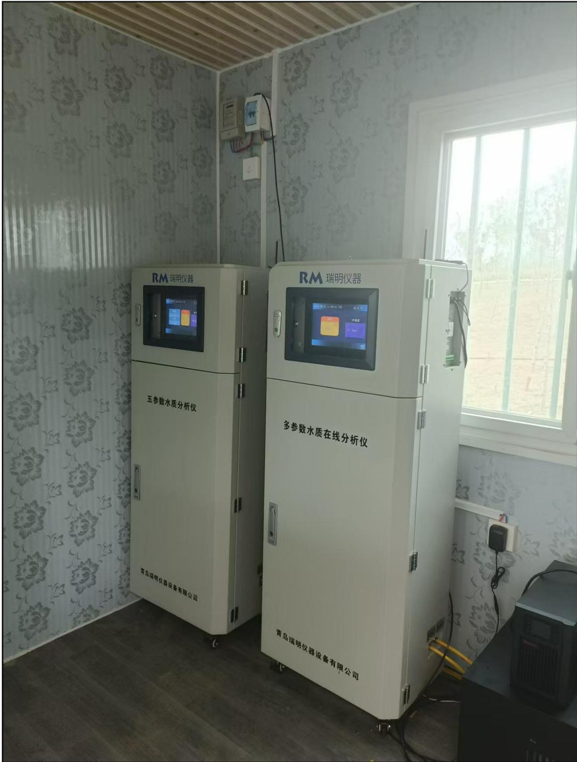
图 4.3-6 退水闸水质自动监测仪
