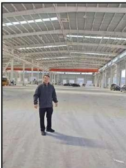
本项目厂房内现状
