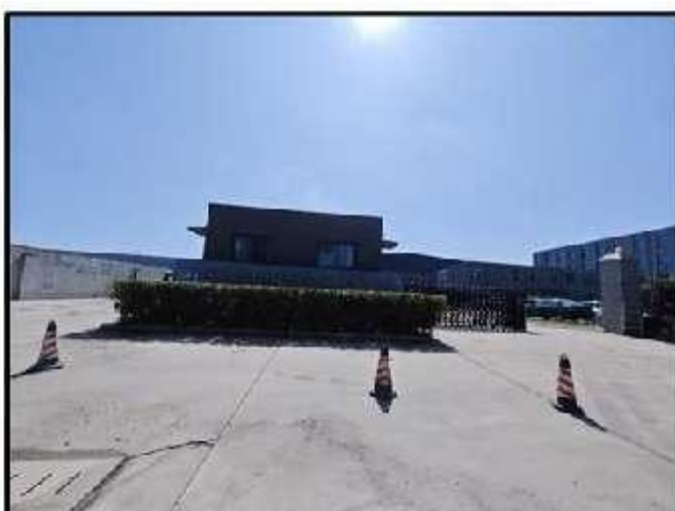
本项目南侧河南省绿豪再生 资源利用有限公司
